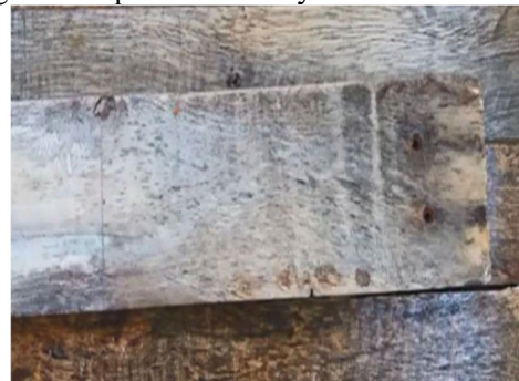
Gambar 3. Membolongkan ujung sisi kayu
