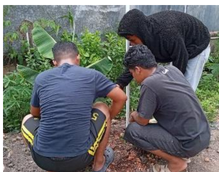
Gambar 2. Proses pemasangan tiang sarana secara gotong royong
