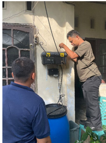
Gambar 4. Alat Yang Sudah Siap Pasang
